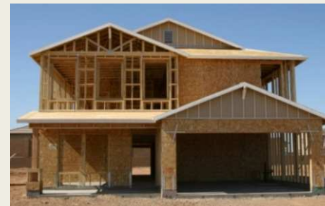
En réhabilitation / Rénovation
