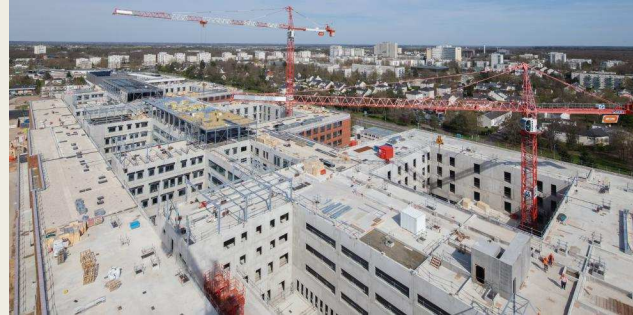
Sur de gros ouvrages
